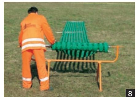
8. Enroulez le treillis pare-neige avec ses poteaux intégrés. Utilisez de préférence l'**enrouleur de treillis**.
