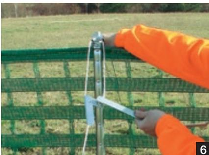
6. Détendez les câbles de haubanage et décrochez-les.
